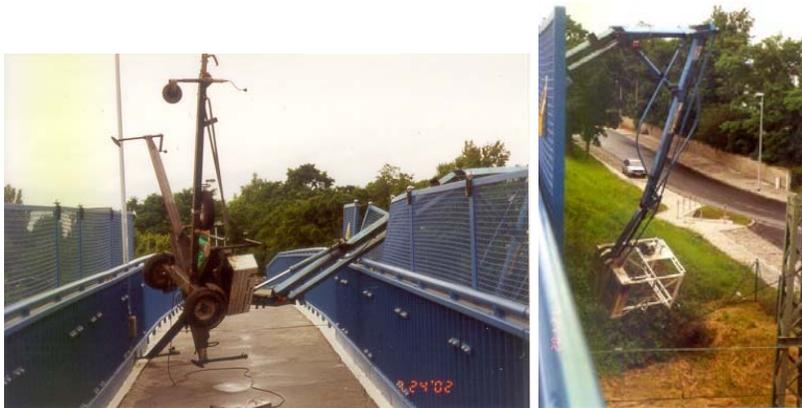
**Bild:** durch unvollständige Abstützung der Arbeitsbühne stürzte der Monteur aus neun Metern Höhe
